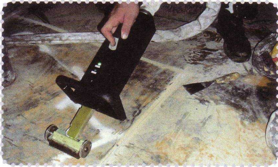
ケミカルタンク - 2007年6月、フランス。タンク底張りの除去。ガラス繊維強化エポキシ。1500 ~ 2000ミクロン。
