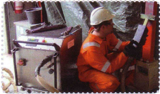
海上石油プラットフォーム - 2007年6月、北海。Chartek難燃材を除去。8000 ~ 13000ミクロン。
